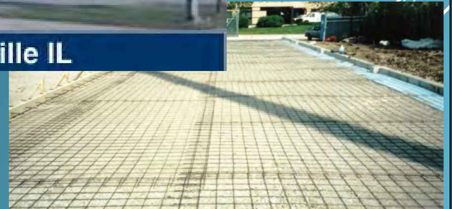
Prime Scaffold, Bensenville IL Prepped for a Slab Pour
