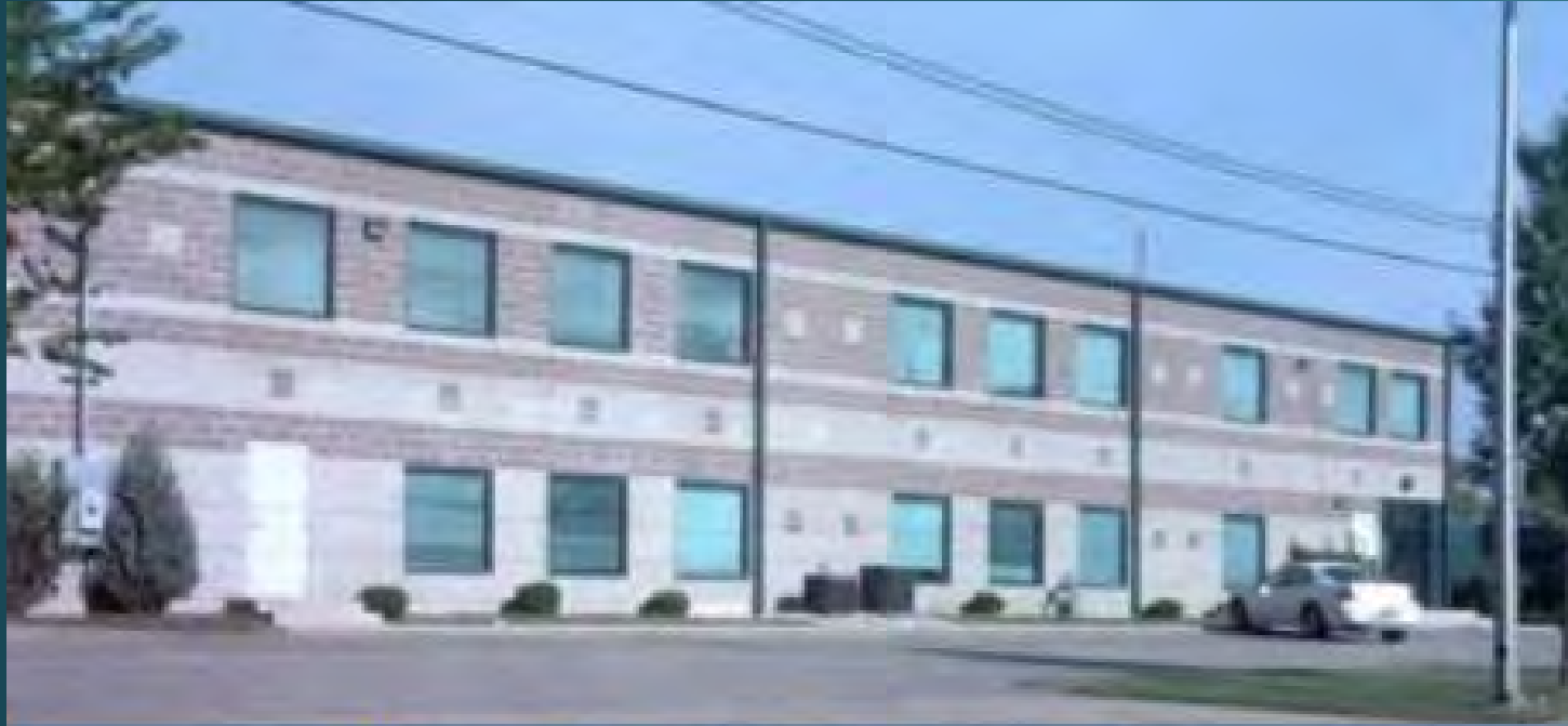
Prime Scaffold, Bensenville IL
